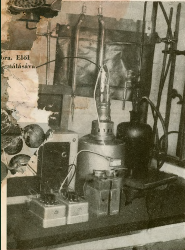
40. ábra. Karl—Fischer-féle víztartalom meghatározó készülék (W. Zentsch felv.)
