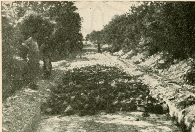
22. kép : Tükörvágás, alapozás
