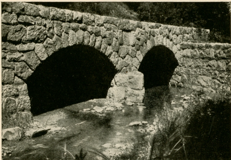
17. kép : Kétnyílású boltozott áteresztő a pilisi erdőgazdaságban
