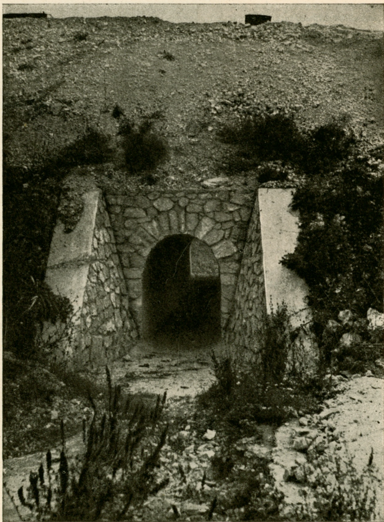
16. kép : Kőrszelet boltozatú áteresztő ferde szárnyfalakkal
