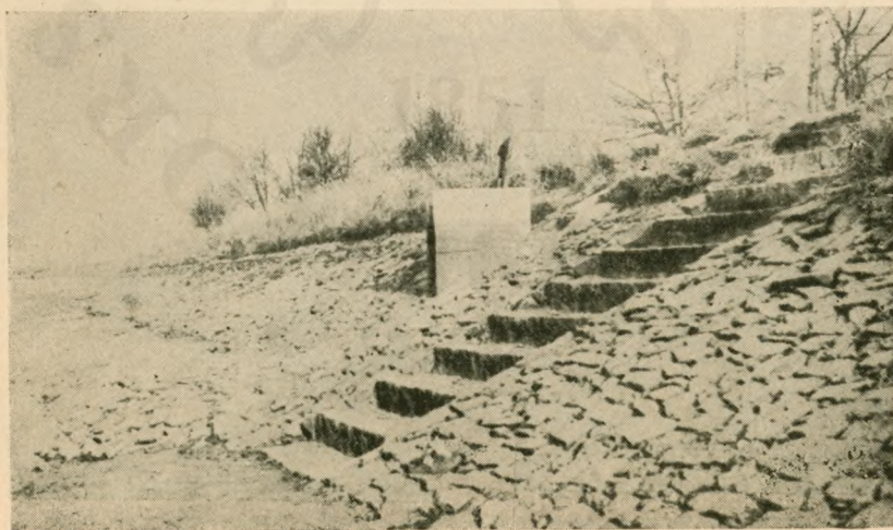
12. kép. Csehszlovákia tőgazdaságaiban ilyen kőburkolatot alkalmaz- nak a hullámverések el- len; a kiürítő zsilipek mellé pedig széles be- tonlépcsőket építenek (Foto: dr. Fóris)
