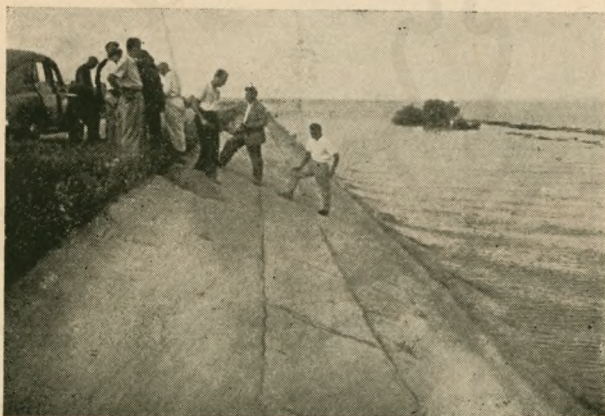
12. kép. Csehszlovákia tőgazdaságaiban ilyen kőburkolatot alkalmaz- nak a hullámverések el- len; a kiürítő zsilipek mellé pedig széles be- tonlépcsőket építenek (Foto: dr. Fóris)
