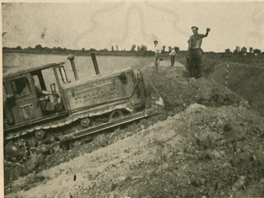
2. kép. Töltésépítés dózserrel
