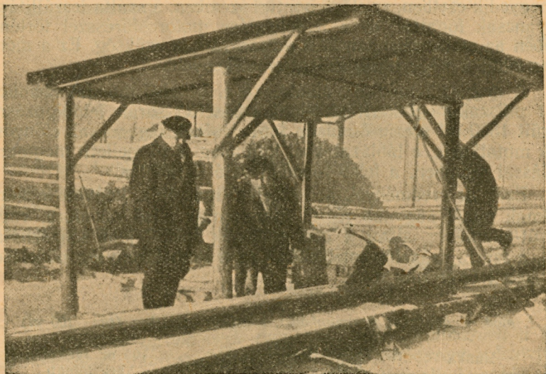
55. ábra. Darabolás körfűrészrel vasúti rakodón.
