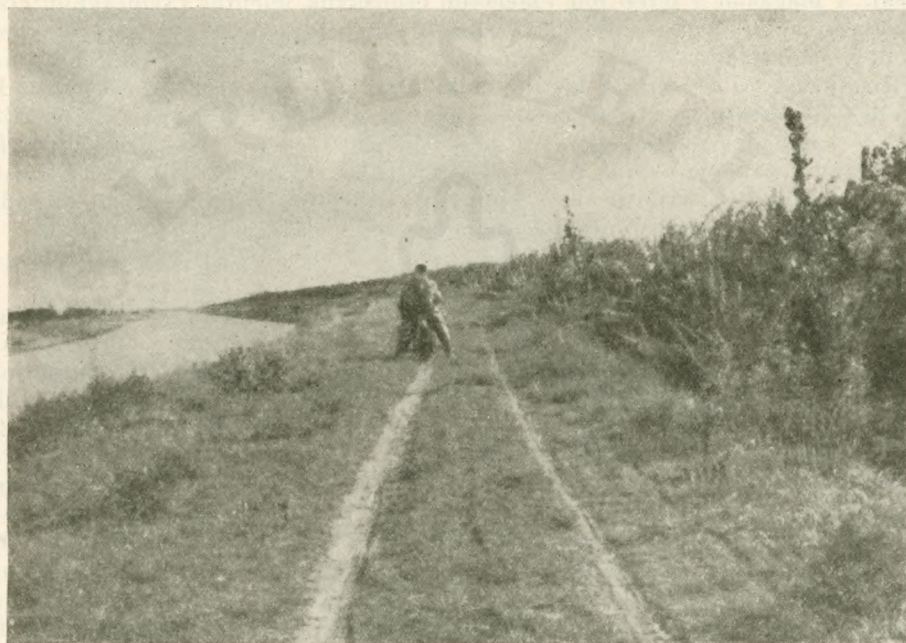
127. ábra. A hajózható csatornák mellett a töltések víz felőli szélén vontatóút visszahagyását írják elő a vízügyi hatóságok. A fásítás csak e mögött kezdődik. Hajdúszoboszló, Keleti Főcsatorna, 3-éves akác-nyártelepítés (Tórn B. felvétele)
