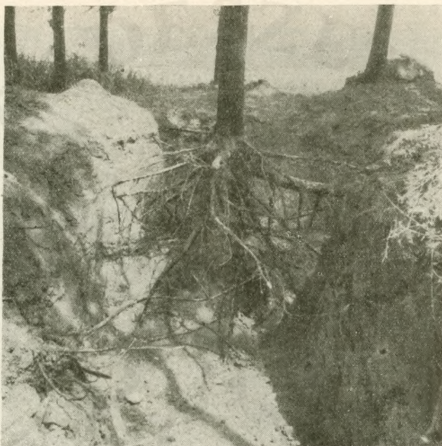
126. ábra. A töltés felső részén álló fa sekély, csak a felső humuszosodó rétegben terjedő gyökeret fejleszt. Nyers depónián telepített 12-éves akác feltárt gyökérzete. Hajdúnánás, Keleti Főcsatorna (Tóth B. felvétele)
