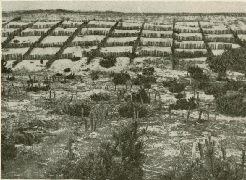
48. ábra. Homokfógo rácshálózat fásítás előtt a Keleti-tenger mellett (MAGYAR P. felvétele)
