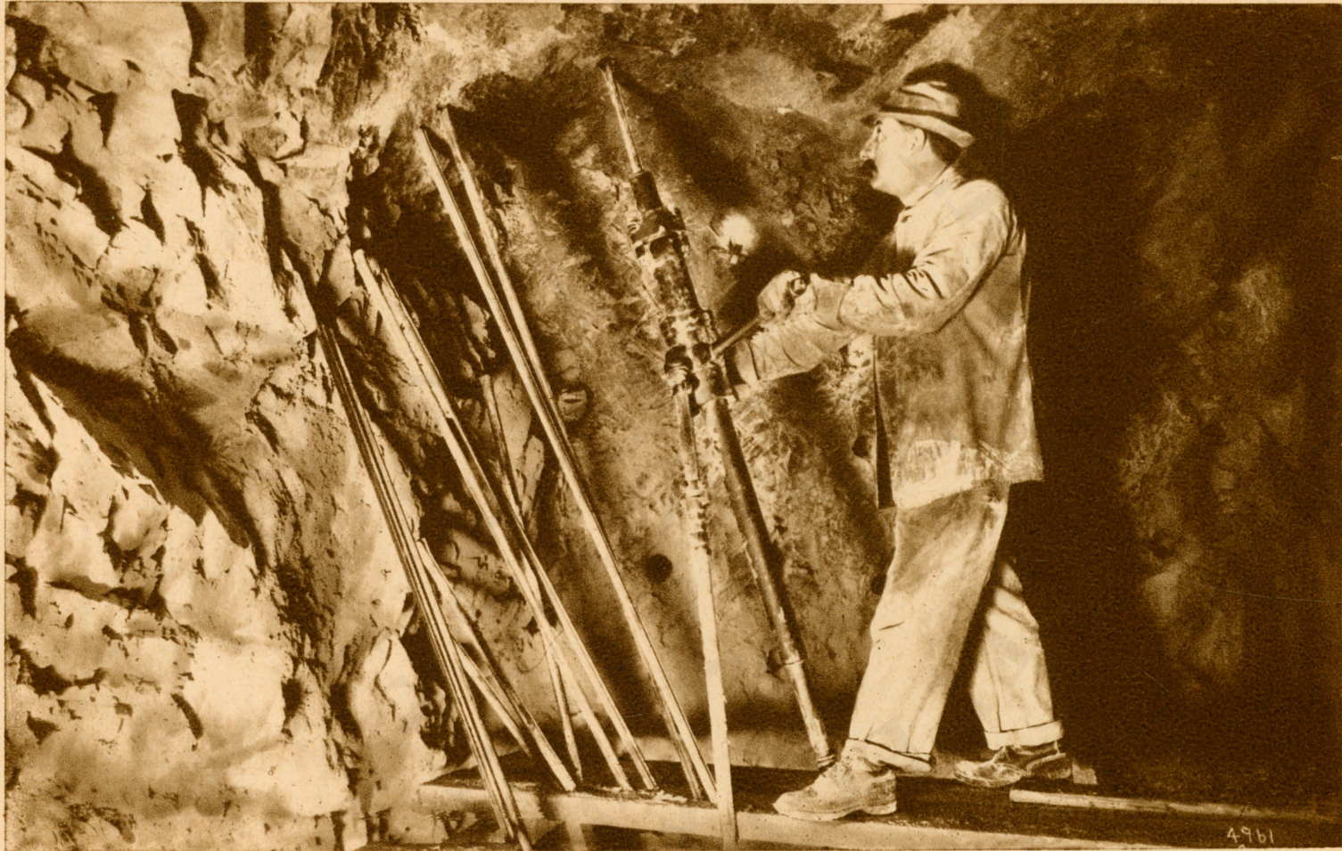
Ingersoll-féle elektro-pneumatikus fúrókalapács a nagybányai veresvizi bányában.
