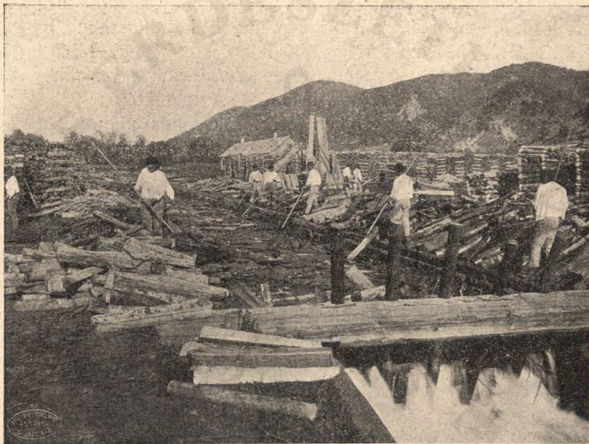
23. ábra. A farakodóba a gerebzsákból torkoló főcsatorna, fát kisedő munkásokkal.
