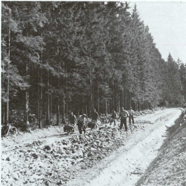
79. Burkolatépítés kézi erővel
