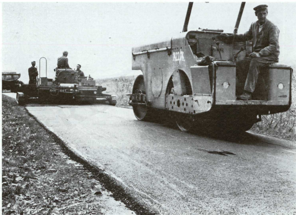
84. Aszfaltburkolat építése finisherrel a Mátrai Erdő- és Fafeldolgozó Gazdaság területén
