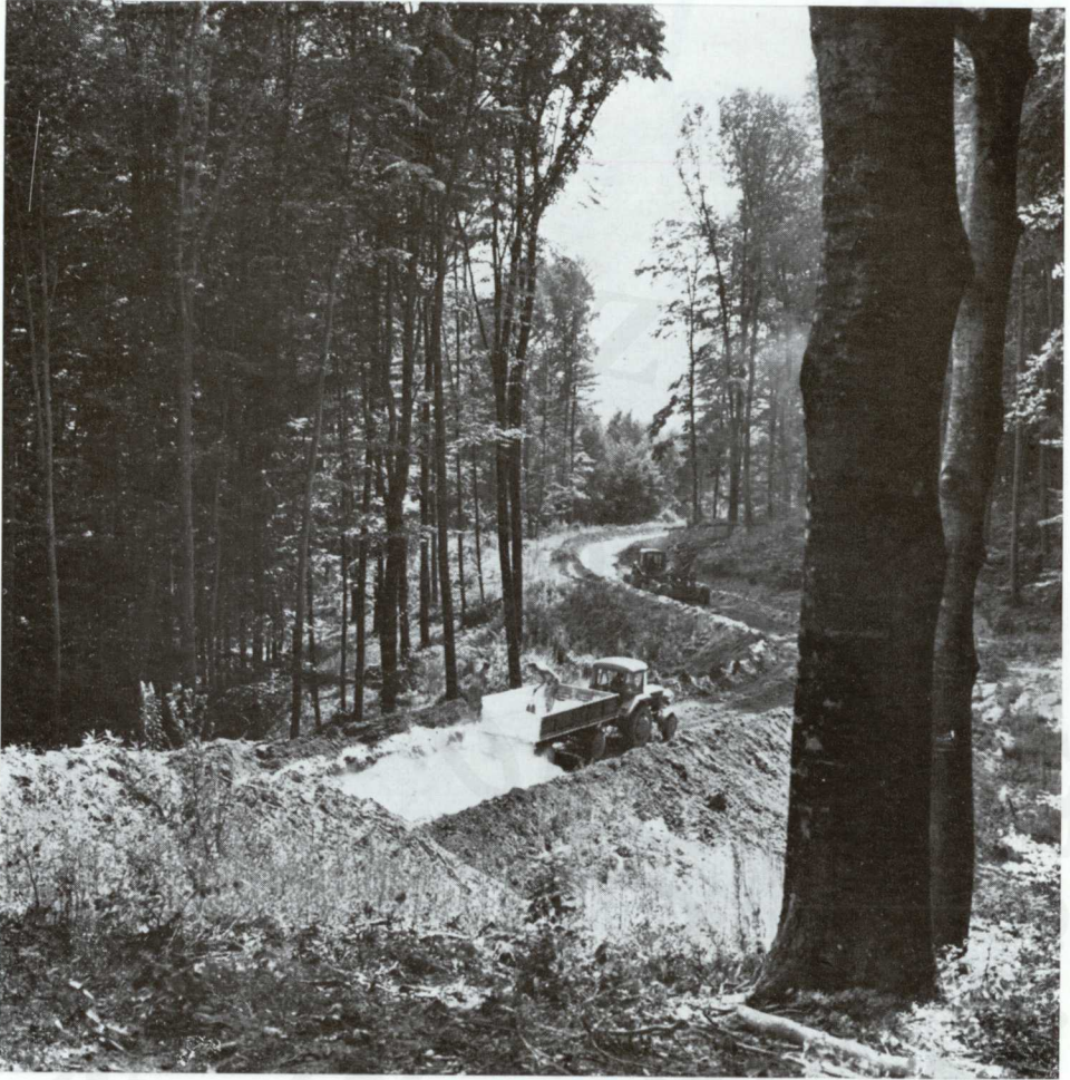
82. Mészstabilizációs útépités Somogyban
