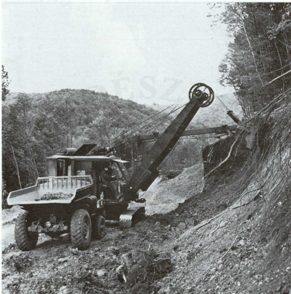
83. Felsővázak kotró alkalmazása lehetővé teszi a rézsüképzés gépesítését
