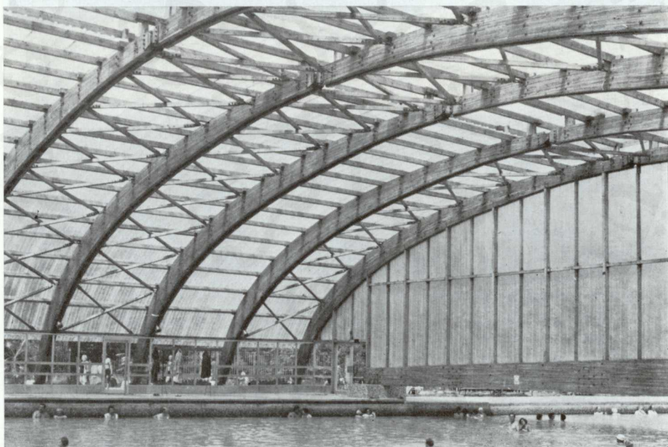
101. A Faipari Kutató Intézet által akácból gyártott, 3 csuklós, rétegelt, ragasztott fatartó szerkezet a harkányi fürdőben
