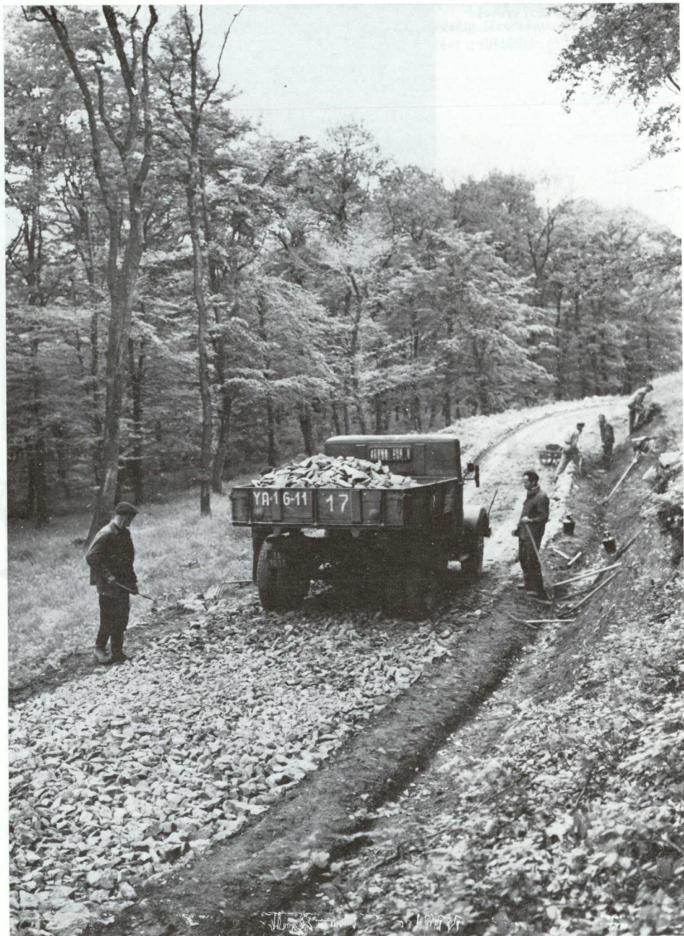
81. Szórt útalap építése
