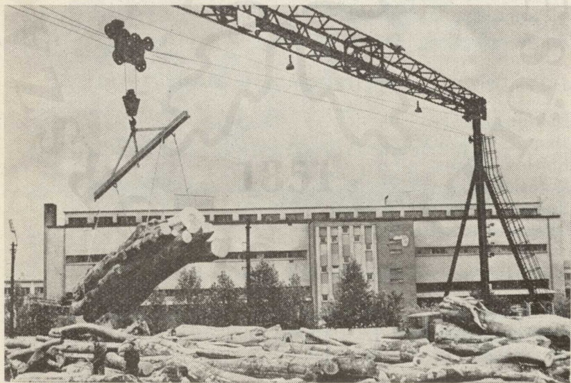
8. ábra. PKZ—5—51 kábeldaru
