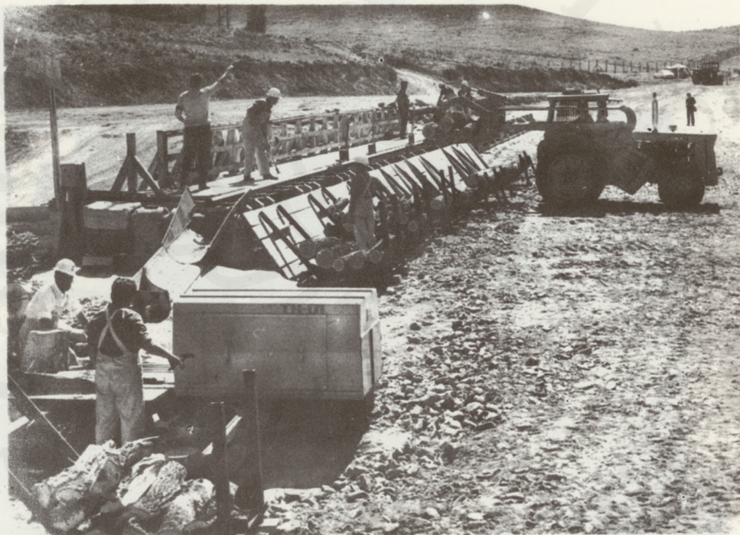
22. sz. ábra Darabolópad és osztályozó
