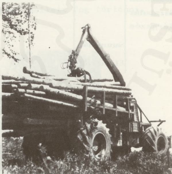
26. sz. ábra TIMBERJACK traktor hosszufa közelítésben
