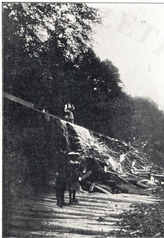
6. kép. Vizes csuszlató a pribinicsi erdőgondnokságban. (Károlyi Árpád felvétele.)
