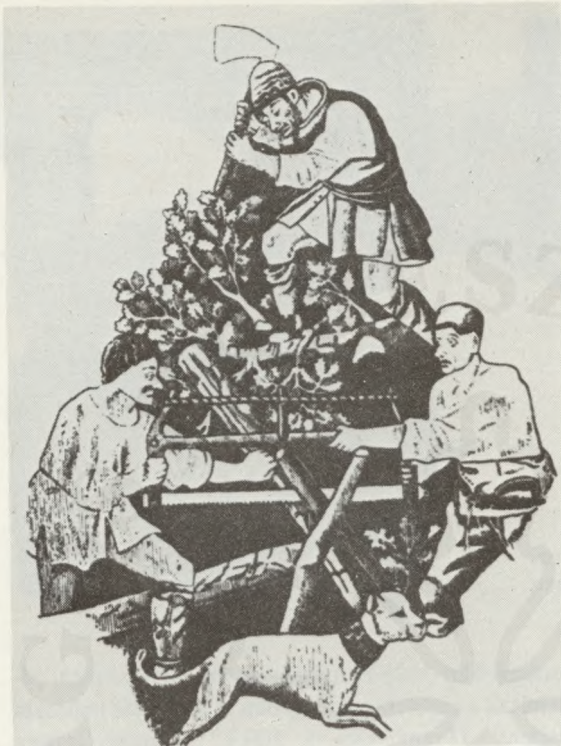
33. ábra: Favágók. A felső alak gallyaz döntőfejszével. A keretes fűrész egészen modern formájú. Burgundia, XV. sz. (Singer, A.: History of Technology. Oxford 1954. II. köt. 391. o.)
