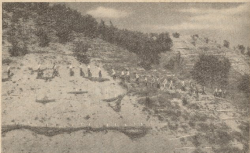
59. ábra. Vízmosáskötés sövényfonásból a piliscsabai kopáron
