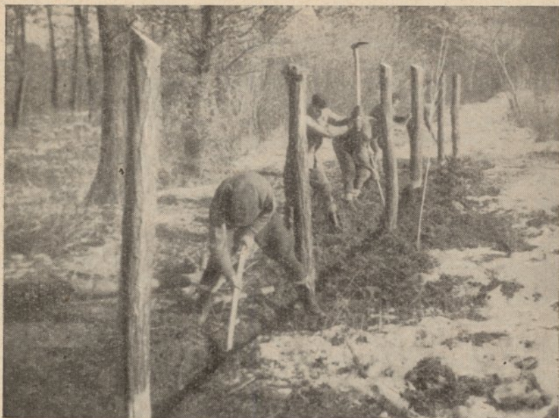
17. ábra. Vadkár elhárító kerítés építése
