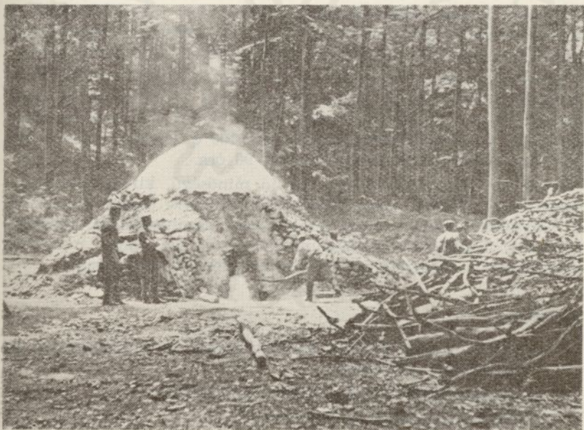
83. ábra. Tábori mészégető kemence, (Benedek A. felv.)
