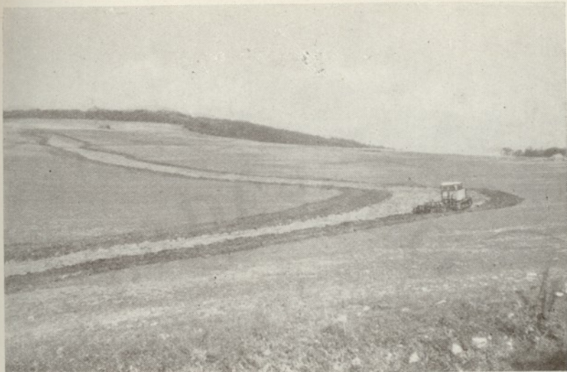
39. ábra. Fűvesített vízlevezető építése
