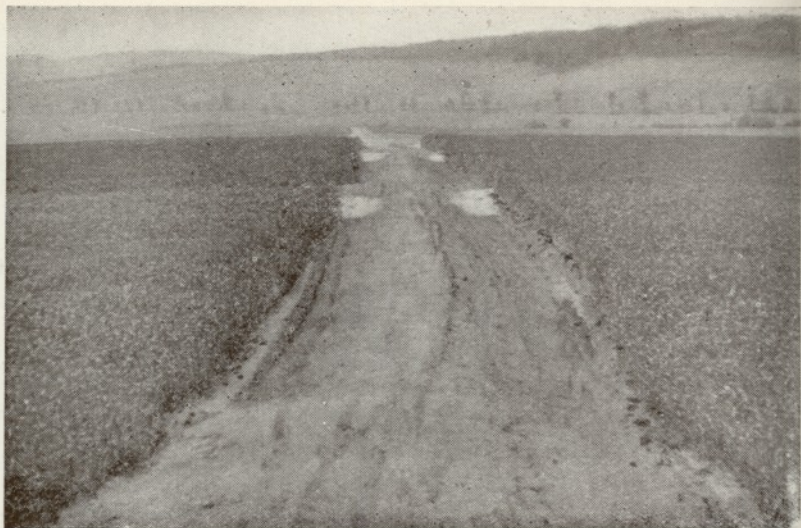
53. ábra. Az úton keresztbe készített „hullámbordák” az út kimosódásának megakadályozására
