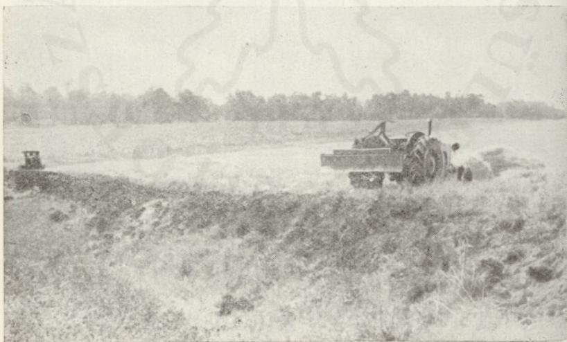
34. ábra. Elbontásra kerülő tereplécső
