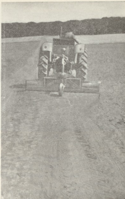
52. ábra. Utolsó simítások a kész úton tereprendező géppel
