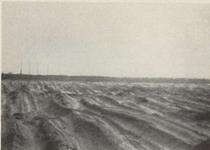
Még el nem planírozott belső deponia. A látható terephullámok mélysége 6—8 m
