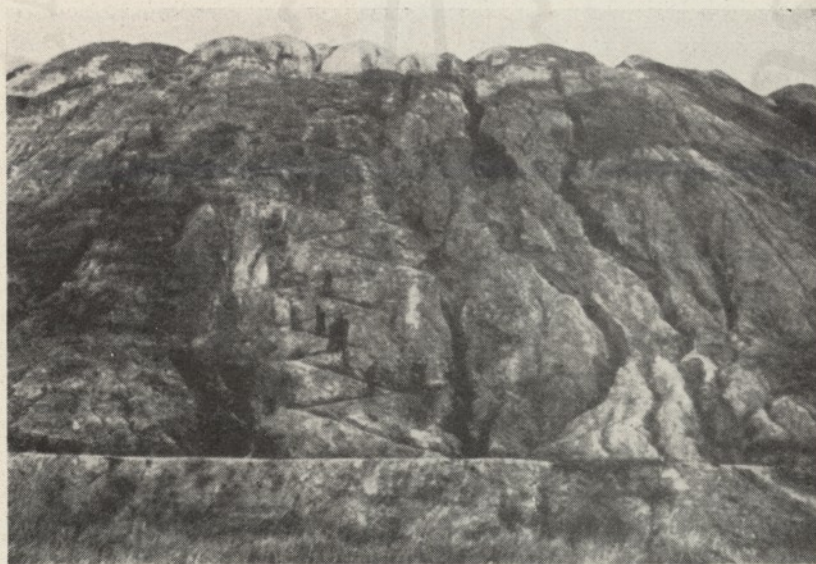
78 m magas hányó, melyen a legördülő anyagot egy mély árok fogja fel. Ez menti a mélyebben fekvő területeket az iszapelöntéstől. A hányó fennsíkjának kiterjedése cca 250 ha
