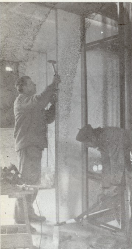
FORVÁL válaszfal beépítése...
