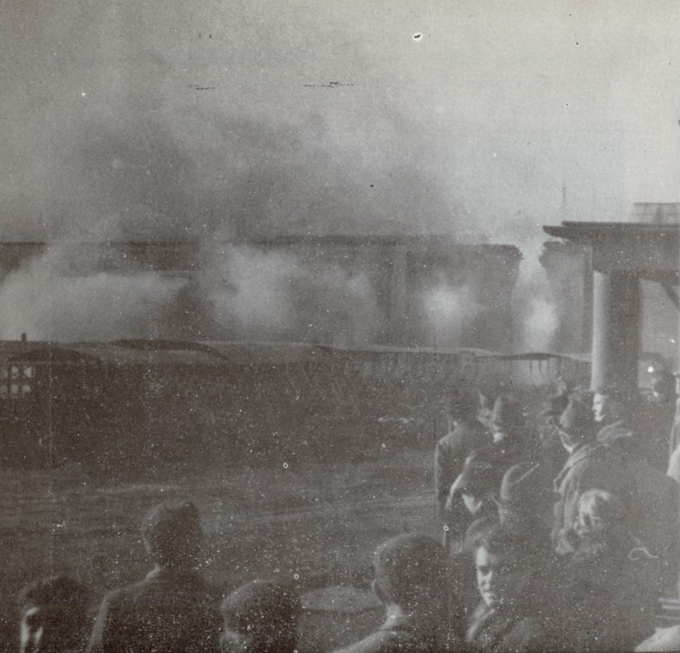
AZ 1970. OKTÓBER 31-ÉN LEALLÍTOTT ELSŐ FORGÁCSLAPUZEM LAPKEPZŐ CSARNOKÁNAK ROBBANTÁSOS BONTÁSA
