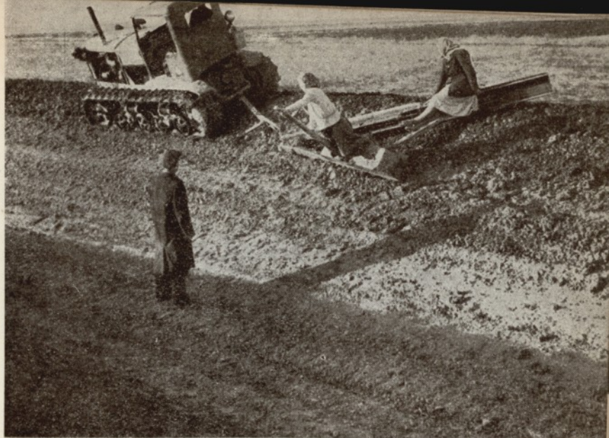
Csatornaépítés lánc talpas traktor vontatta sáncolókével.
