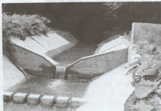
A vízgyűjtő területéről eltávozó víz mérésére szolgáló műtárgy.
