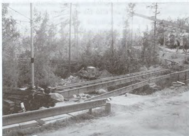
Egy elpusztult híd tartószerkezetének helyreállítása a poprádi keskeny nyomtávú vasútvonalon.
