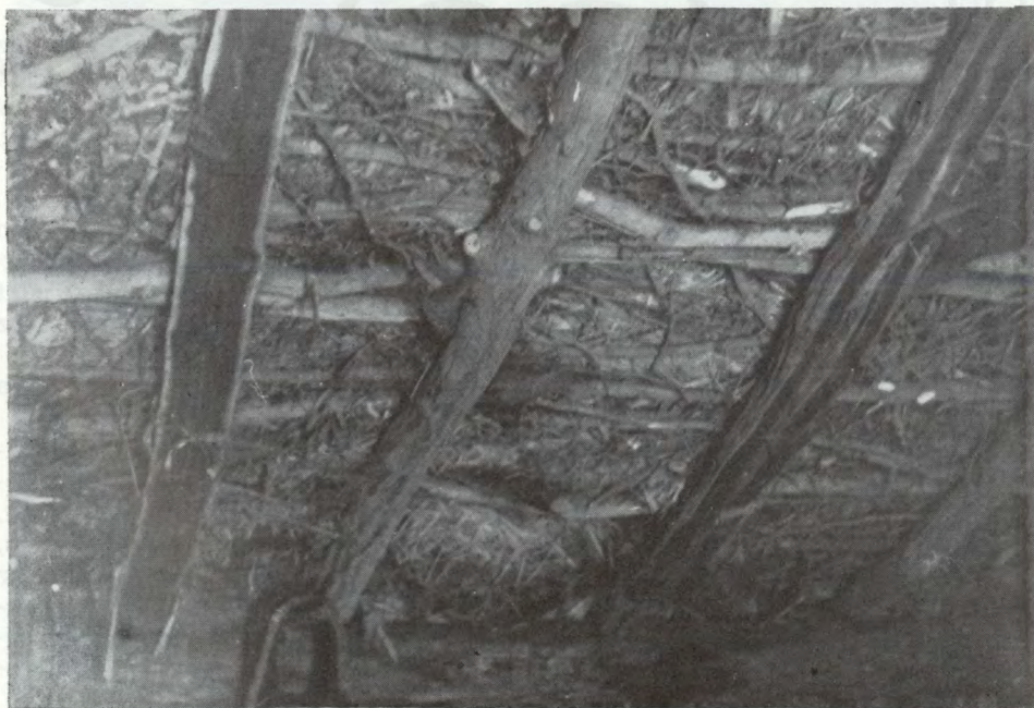
3. kép. A tetőszerkezet belülről
