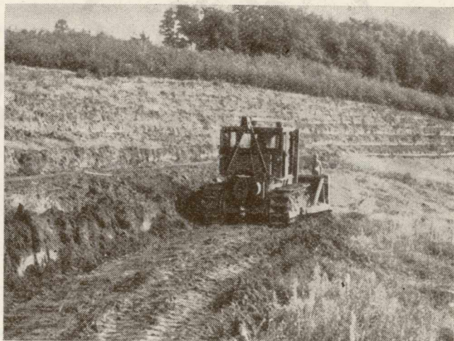
1. ábra. Teraszkészítés Sz-100 jelű erőgépre szerelt D-157 típusú tolólappal
