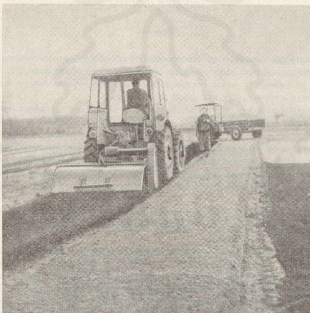
8. ábra. A tőzeg beforgatása és simítás géppel
