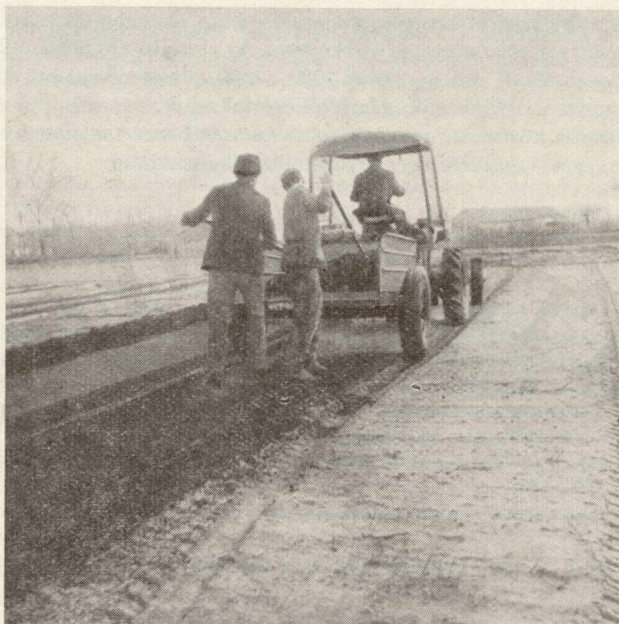
7. ábra. Tőzeg terítése mozgó gépről
