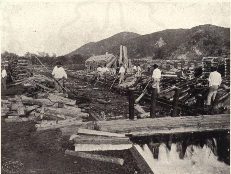
A gereb főcsatornája.
