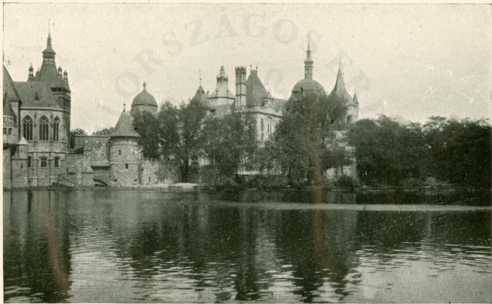
A M. KIR. MEZŐGAZDASÁGI MÚZEUM RENAISSANCE ÉPÜLETE.
