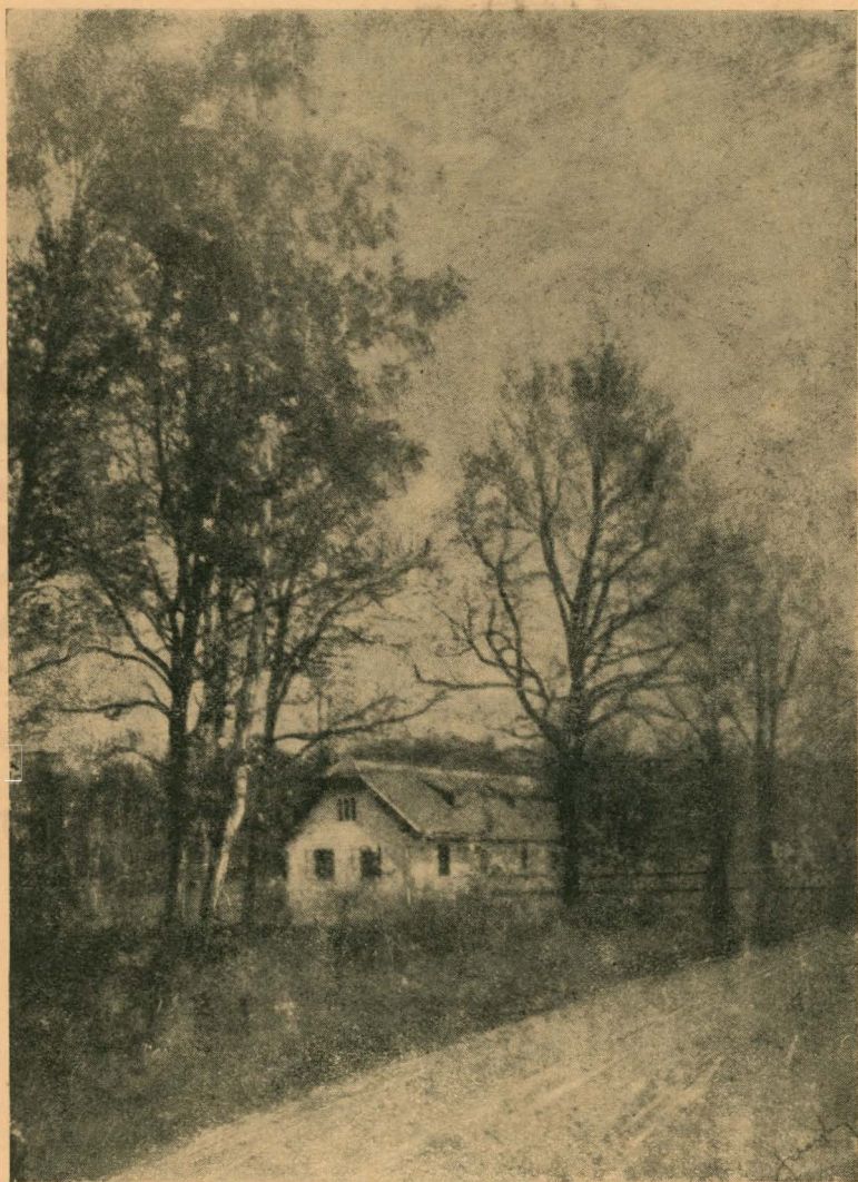
68. ábra. Újkúti erdőöri lak.
