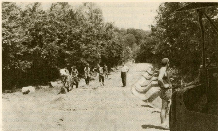
2.87-13. ábra. Itatott makadám építése a szurkosárokúton (Délzalai Áll. Erdőgazdaság)
