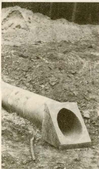
2.63-15. ábra. Különböző előfej kiképzések. a) Előregyártott előfej burkolt utófenékkal. b) Előregyártott előfej. c) Természkő előfej.
