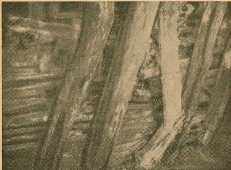
43. ábra. Bányatámfák gombásodásának hatása
