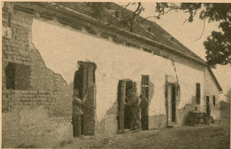
48. ábra. Mezőgazdasági épület faanyagainak szükségszerű cseréje
