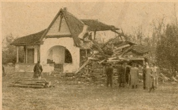
A buvau erdészház is összedőlt a bajai nagy árvíz következtében.
