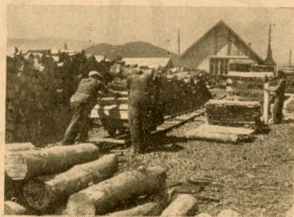
Az előkészített tűzifahasábokat repülővágányokon szállítják be a feldolgozó csarnokba
