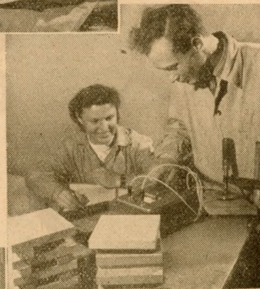
Madari László és Ric Imréné nedvességtartalom mérést végez Siemens-nedvességmérő készülékekkel
