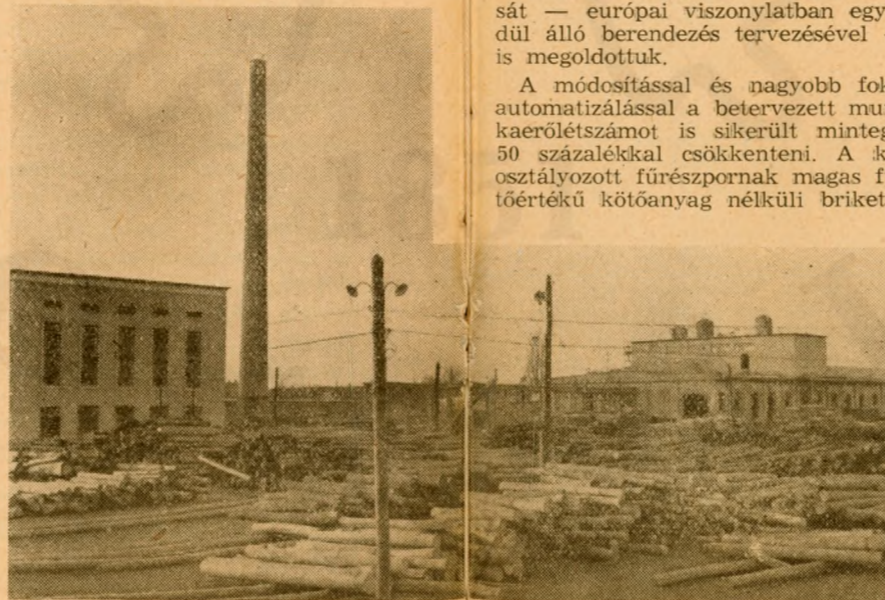
Az épülő új üzem látk De, elől a rönktérrel
