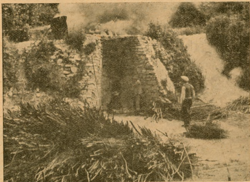
31. ábra. Erdei tábori mészégető-kemence, (Süttői típusú).
