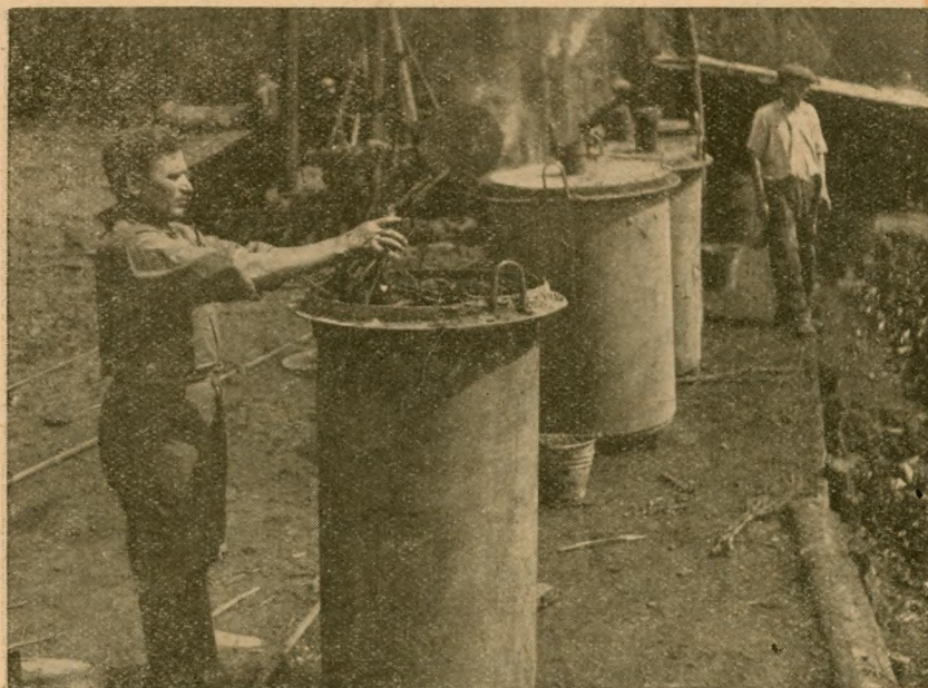
20. ábra. Vándorretorták töltés alatt.
