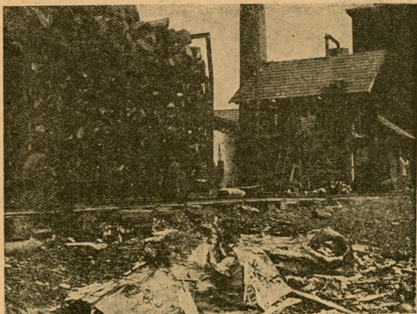
23. ábra. Álló retortához kocsin faanyag beállítás.
