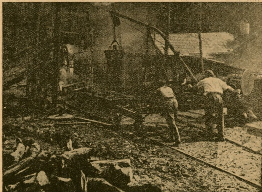
21. ábra. Vándorretorták kemencébe helyezése futókocsival.
