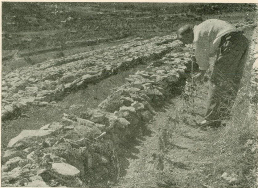
34. ábra. Árkos (ugróárkos) kiképzés. Sziklás, törmelékes 15^\circ -os és ennél meredekebb lejtőn alkalmazható. Egymás alatti távolsága 2–3 m, amit a törmelékesség és meredekség mértéke szab meg.
