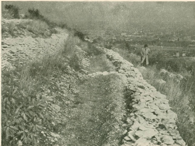
35. ábra. Terraszos, terraszos-padkás kiképzés, 10-20^\circ reliefben, a nagyobb szikladarabok levándorlásának megakadályozására alkalmazzuk.
