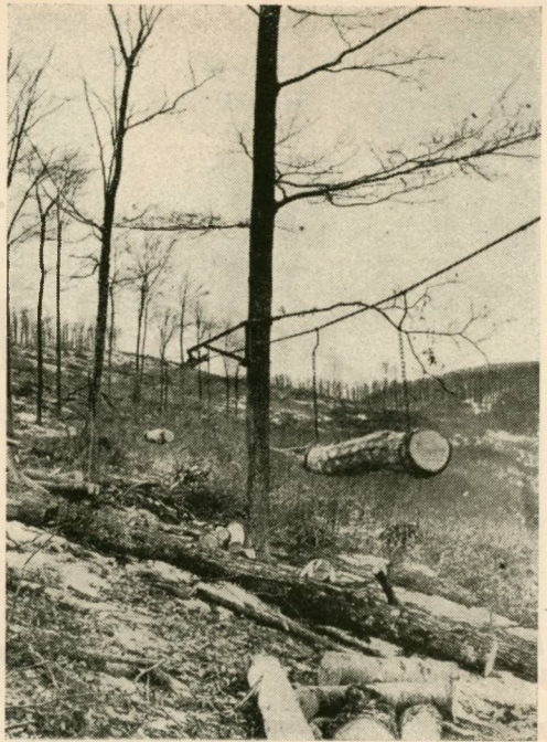
30. ábra. Lasso—Cable közelítő berendezés
