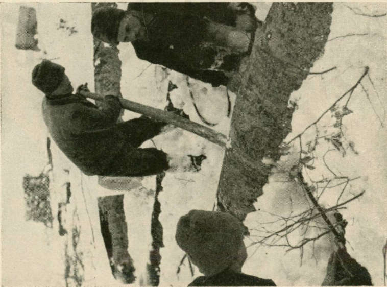
28. ábra. Darabolás villamjűréssel
