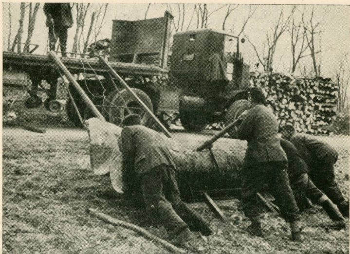
Amíg a gép az emberi munkát fölváltja, ilyen fáradtságos és életveszélyes eljárással lehet a rönköket fölrakni (Mecsek, 1946)
