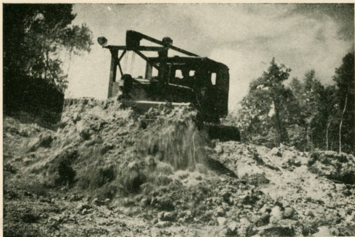
Eltérően a multtól, feltárol utakat építünk — szovjet buldozer utat tör az erdősejben ; egy műszakban 60 kubikos munkáját végzi el (1951)
