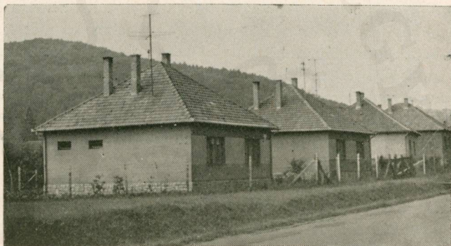
Árpádtetőn korszerű épülő új utcásor lakásokkal
