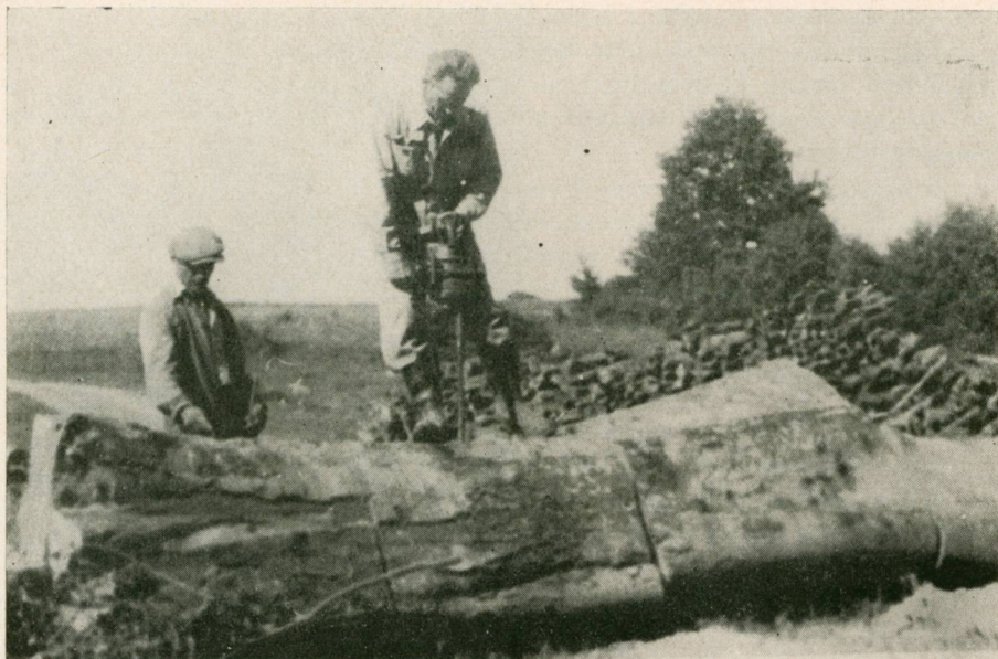
A tuskórobbantás előkészítése a mecsekiek által szerkesztett elektromos meghajtású „kanalas” fűrővel.
