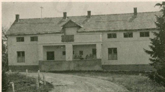
Az árpádtetői munkásszállás.
