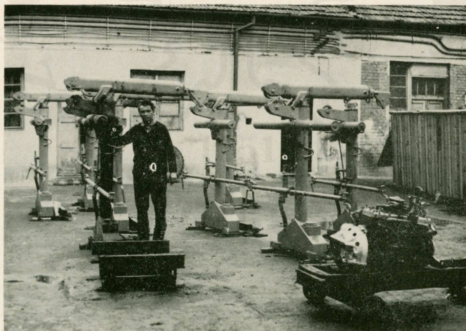
Az ország minden részéből a műszaki erdészet pécsi műhelyébe érkeznek a HIAB (svéd) daruk felújításra.
