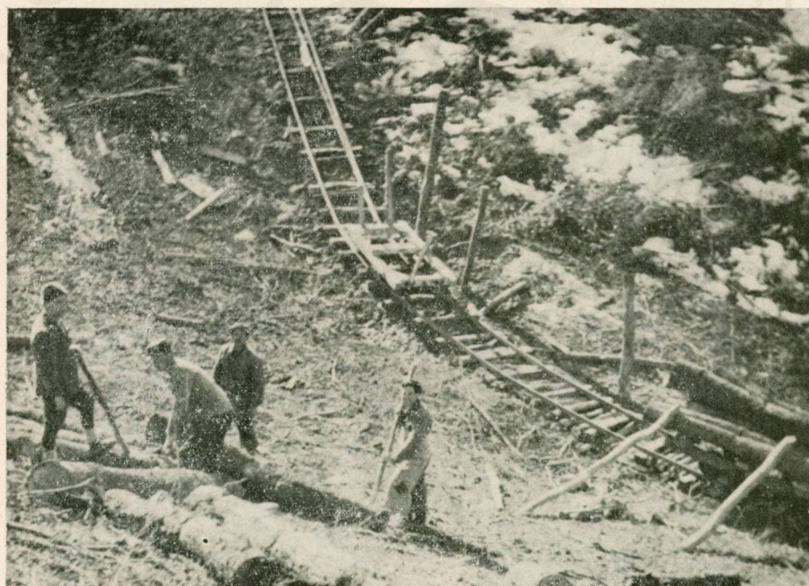
A dolina mélyéről „repülővágányon” csörlőzik föl a faanyagot.
