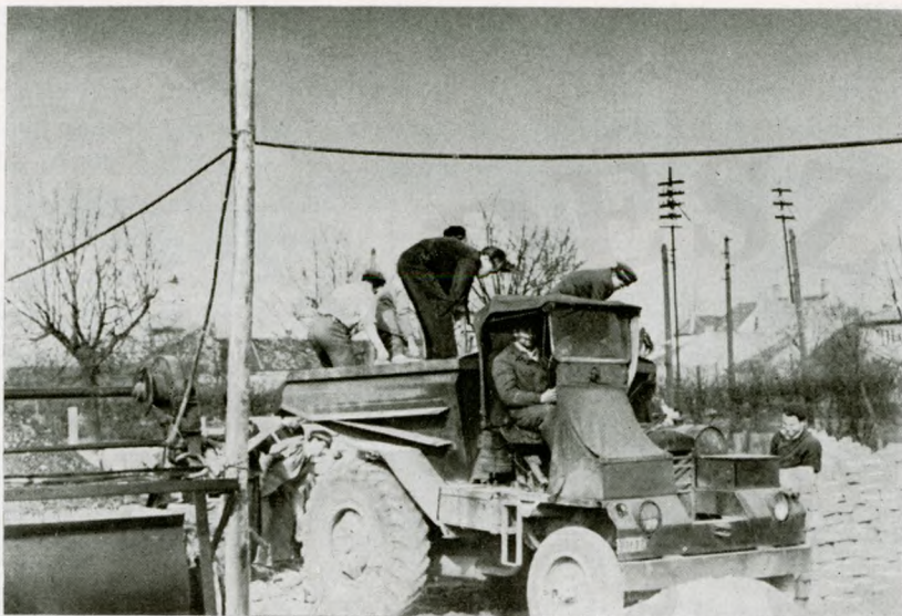
Indul a KISZ-ház építése. A Vasöntöde dömperje segít az építkezésnél
